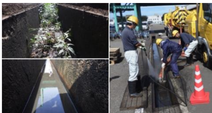
側溝清掃の様子
