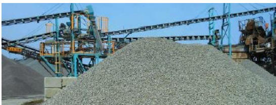
(写真 11) ベルトコンベアによる移送
