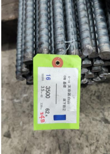
▲現場毎に配色を変えている荷札
