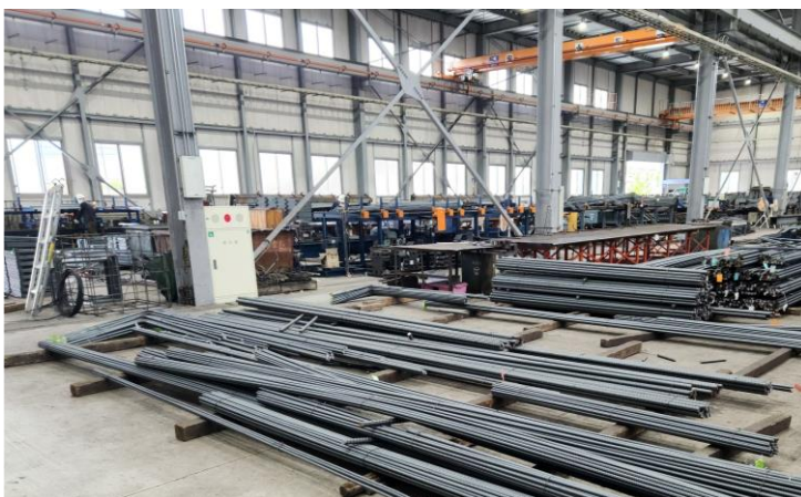
▲外光を取り入れるため窓を多く設置した工場壁面
