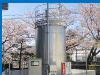
円筒型タンク 概寸: \Phi 2250 \times 3570H
