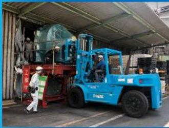
機械設置工事
