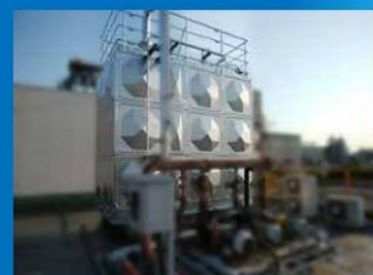
角型タンク (パネルタンク選定・購入品) 概寸: 3500 \times 2000 \times 3000H
