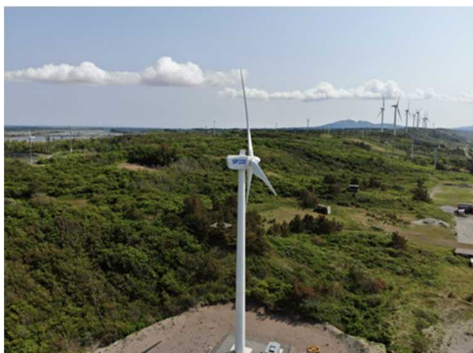
山鋼プラントック秋田男鹿第1発電所
