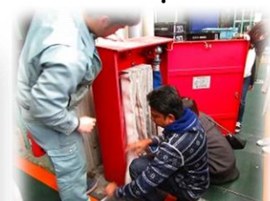
消火栓の確認
