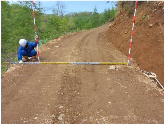
〈勾配緩和の様子〉
