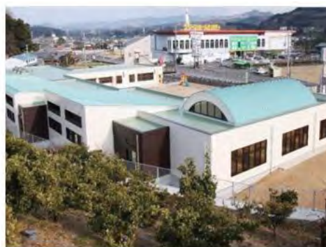
すみだこども園 新築工事
