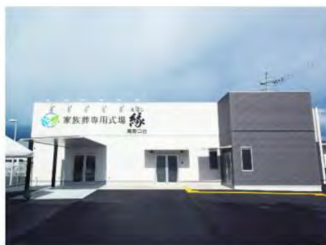
縁様 高野口店 新築工事
