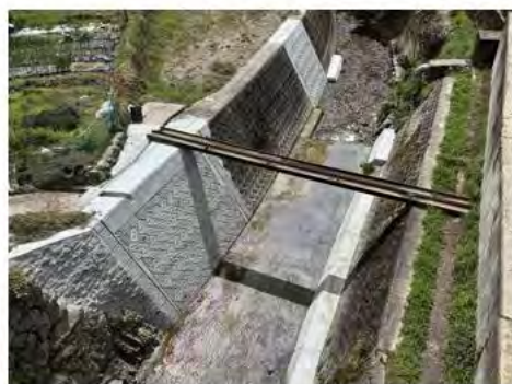
橋本川(矢倉脇) 河川 災害復旧工事
