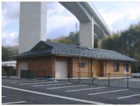
尾崎集会所 新築工事
