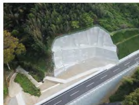
紀の川左岸地区 西洪田 (その17) 工事
