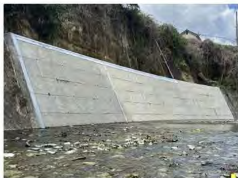
橋本川(御幸辻) 河川 災害復旧工事
