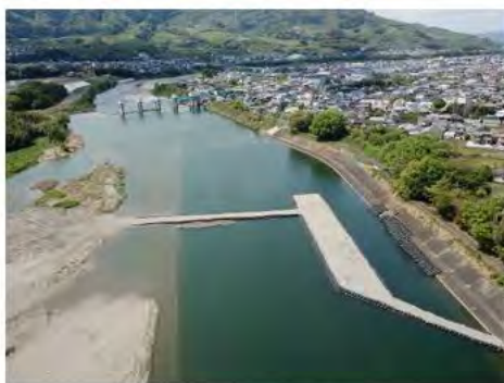
紀ノ川小田地区護岸 補修工事
