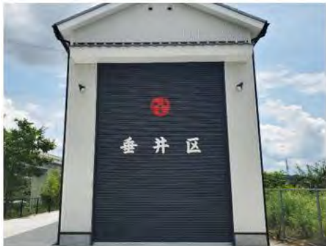
垂井区だんじり小屋 新築工事
