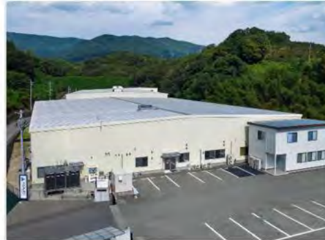
株式会社興栄ケミカル様工業所 新築工事
