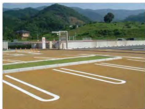
国保橋本市民病院外溝 土木工事
