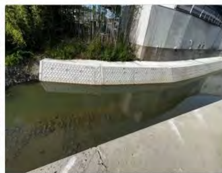
大坪川堤防 改修工事
