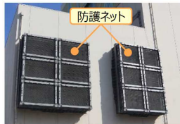
建物通気口部等への飛来物防護設備の設置 (2号機)
