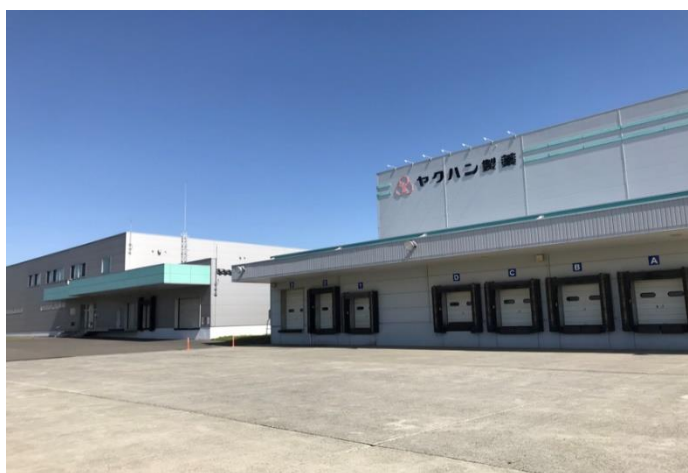
写真：工場（液剤棟）および物流センター
