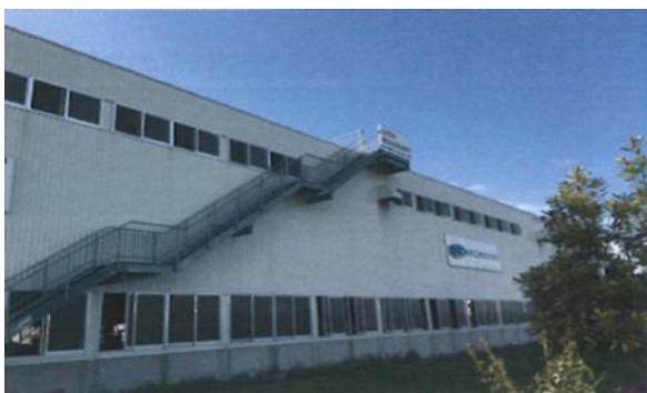
（坂田工場A棟の屋上への避難階段）
