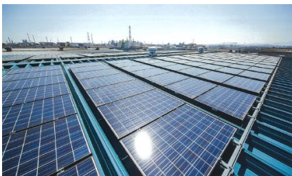
〈千歳E号倉庫屋上〉
