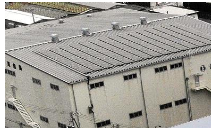
〈千歳F号倉庫屋上〉
