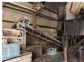
プラスチック処理
