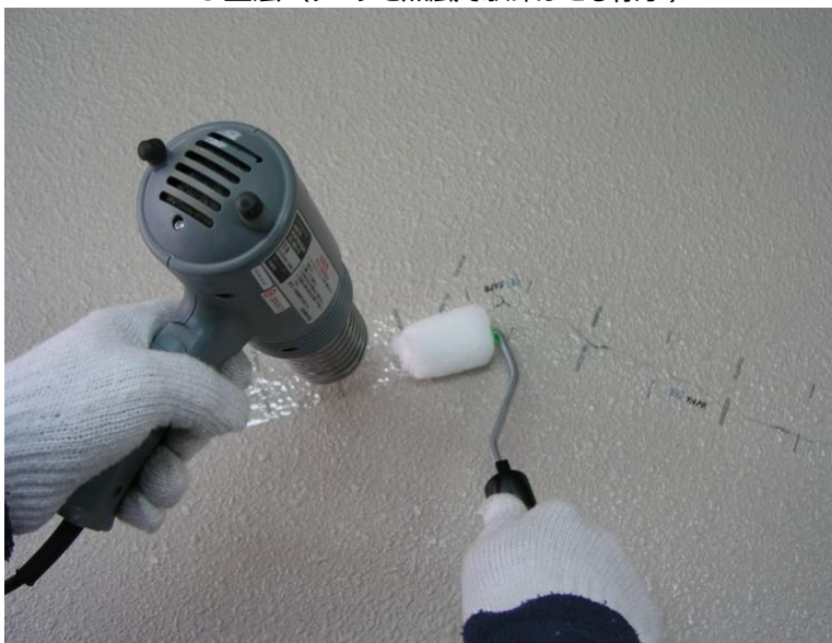
TNC工法（テープを熱風で馴染ませる様子）
