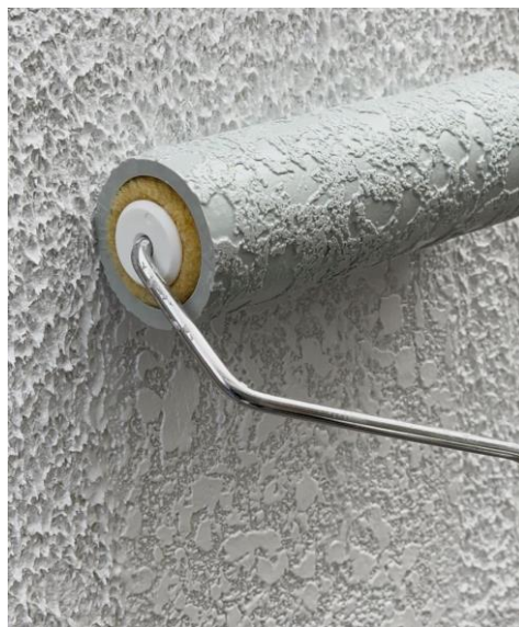
魔法ローラーによる塗装作業
