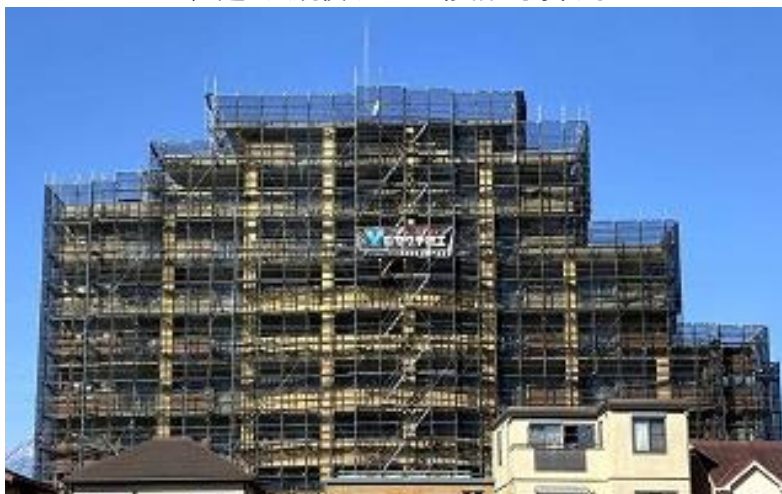
80 戸超の大規模マンション修繕を手掛ける
