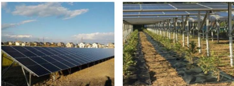
図表 19 (左) 低圧・分散型太陽光発電設備、(右) ソーラーシェアリング
