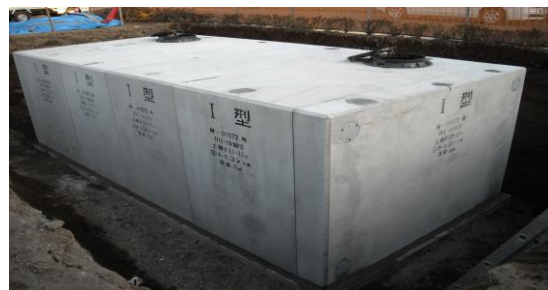
耐震性貯水槽
