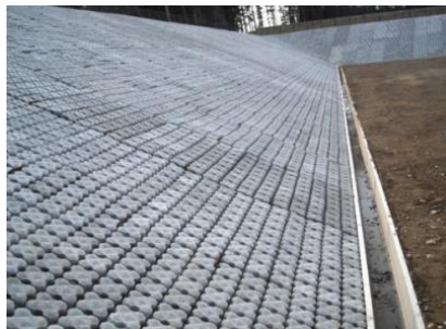
護岸ブロック
