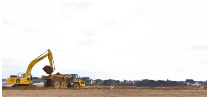
水戸市新ごみ処理施設用地造成工事|水戸市(一次下請)
