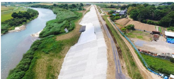
前河原築堤護岸工事 | 国土交通省 関東整備局 下館河川事務所 (一次下請)
