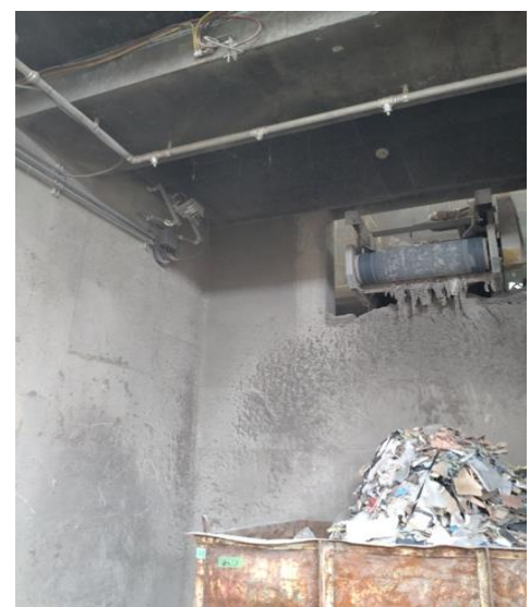
【図表2-2-5 温度センサーとスプリンクラーによる初期消火装置】
