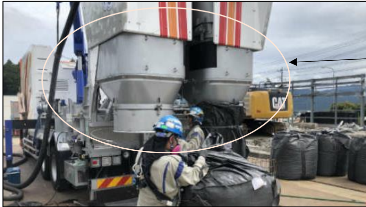
ツインバックを活用した作業風景
