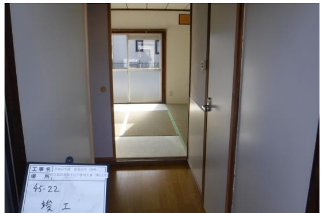
▲災害復旧工事
