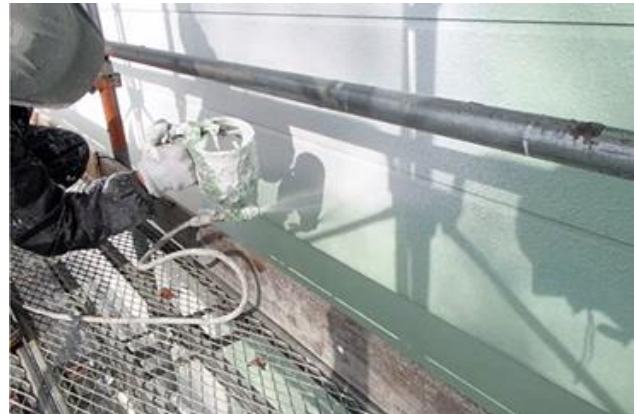
▲ 外壁修繕の様子
