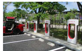
〈EV充電器の施工事例〉
