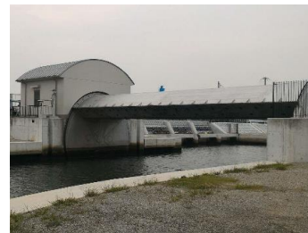
八家川第五ポンプ場 ・主原動機 ・兵庫県姫路市/2024年3月
