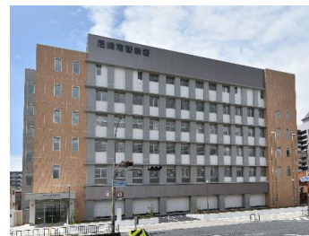
尼崎南警察署庁舎棟 ・電気設備工事 ・兵庫県尼崎市/2023年9月
