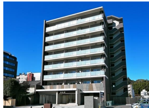
丸伊呉服店ビル新築工事
