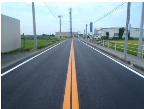
舗装補修工事 宇都宮結城線その4 (道保全単)
