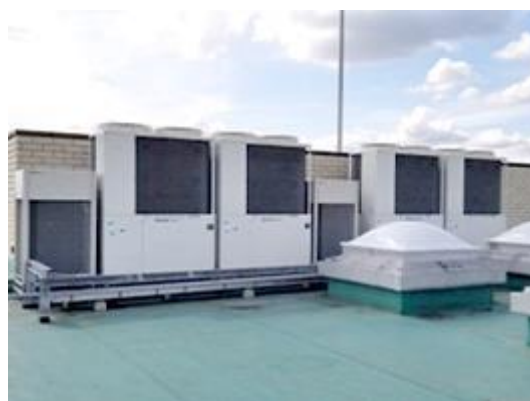
本社に設置された ハイブリッド型空調の室外機
