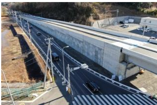
一般国道 119 号 上戸祭立体建設（仮称）工事
