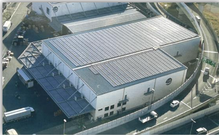
第一第二倉庫屋上に設置された太陽光パネル～商工中金経済研究所撮影
