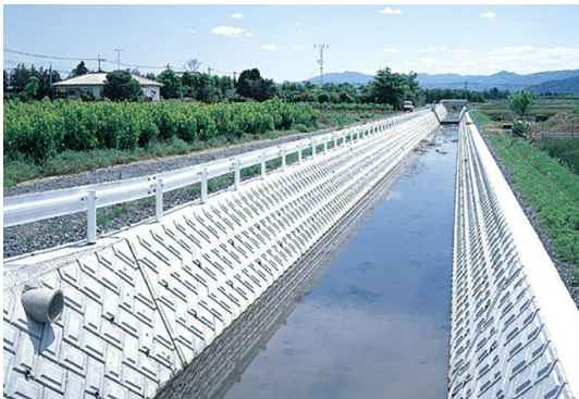
藤治川 護岸工事
