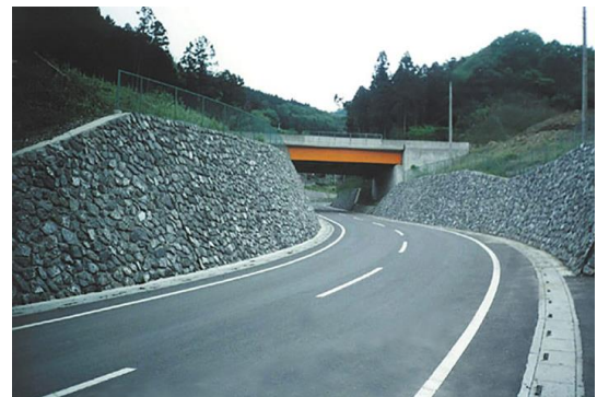
風布 A ランプ工事
