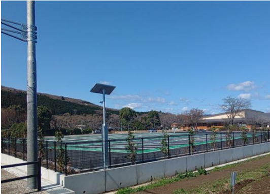
道の駅おがわまち 駐車場拡張工事
