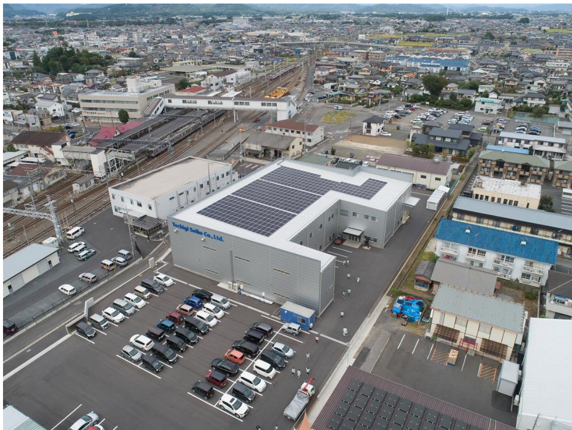
管理棟（写真右下）と製造棟（写真中央）に設置のソーラーパネル
