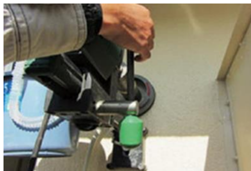
コア抜き工事
