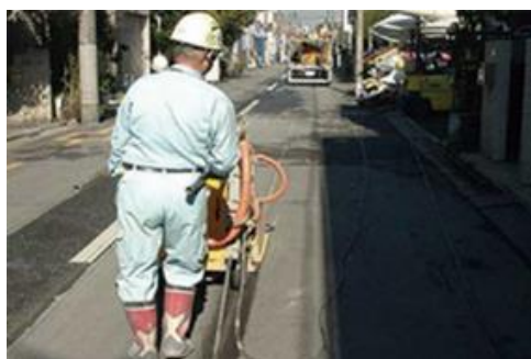
カッター工事
