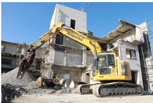
総合解体工事
