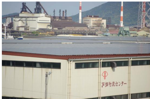
〈西港物流センター屋根〉
