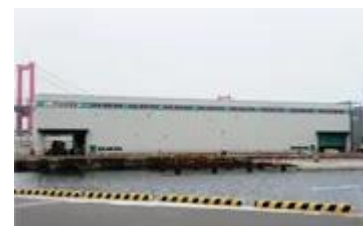
〈コイル材保管倉庫〉
