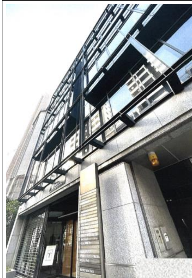
本社が入る京町堀スクエアビル～商工中金経済研究所が撮影
