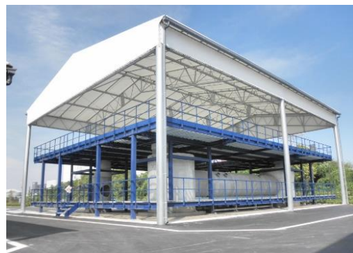
風：屋根・荷捌場として活用
