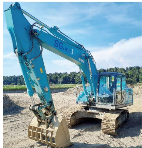
写真⑥ バックホー（エスジー提供）
